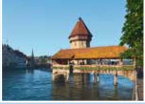
Kappelbrücke, Kanton Luzern
